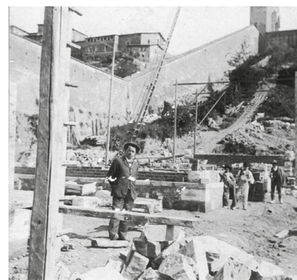
Maestranze a lavoro durante la costruzione del Ponte di Derna.
