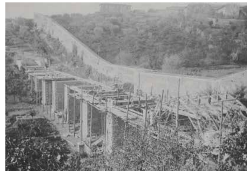
Il Ponte di Derna in fase di costruzione.
