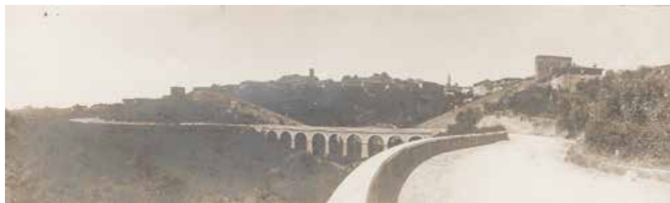
Tratto superiore di via Gigli appena realizzato.
